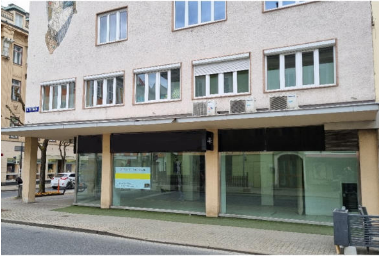
Untergeschoss Nebenflächen Lagerräume:
