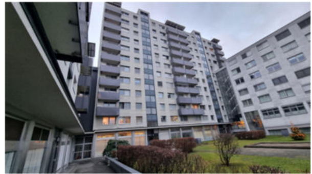
Ansicht Innenhof Getreidegasse
